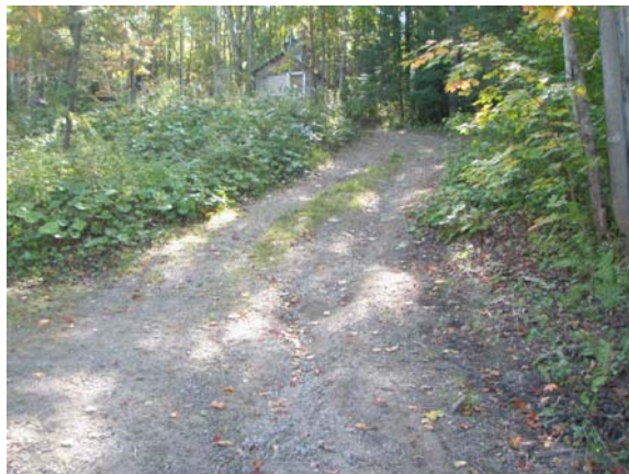
Vue d'une pente forte créant de l'érosion (ravineaux) au niveau du chemin
