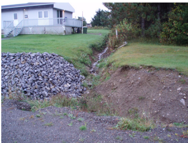
Exemple d'un fossé nécessitant une naturalisation et une stabilisation - tronçons 23 et 24
