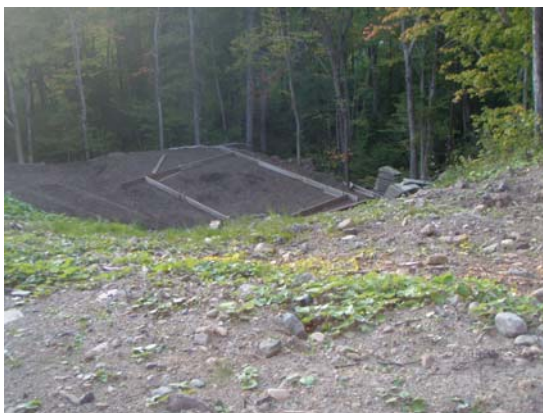
Vue d'ensemble des travaux
