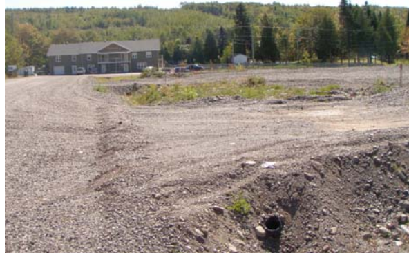
Vue d'ensemble d'une partie des travaux en cours
